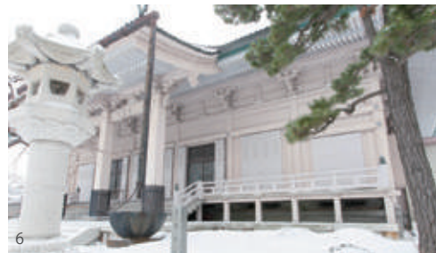
1. 本堂の中。グレーの柱と梁はコンクリート、その奥のご本尊を安置する内陣や天井は木でできている 2&3. 内陣の台座の細工。いまでは失われてしまった技術も。立体的な獅子の像も珍しい 4. 二十間坂から見る本堂。特徴的な屋根は、鉄筋コンクリート造の屋根の上に瓦をのせている 5. 懸魚（げぎょ／写真右上のハート型のもの）などの意匠や柱、垂木はモルタル 6. 細工が施された白っぽい扉は鉄製
