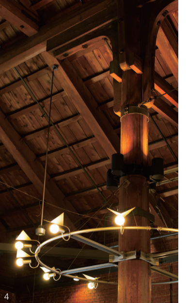
1. 金森ホールのレンガの積み方は、堅固な「イギリス式」。壁の厚さは50cmもある 2. 入口上部の番号は、倉庫業の名残。この番号を目印に荷物の出し入れがおこなわれた。馬車が入るように内部は広い 3. 梁で屋根を支える構造は、現代では考えられないそう。当時の技術には驚かされてばかりと奈須川さん(写真は金森ホール内) 4. 一本の柱をまるごと使用した柱。荷物を引っ張る道具「この」を引っ掛けた傷跡など当時の面影は、函館ヒストリープラザ内の函館ビヤホールで見られる
